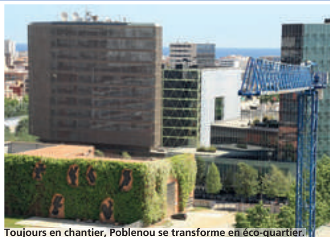
Toujours en chantier, Poblenou se transforme en éco-quartier.
